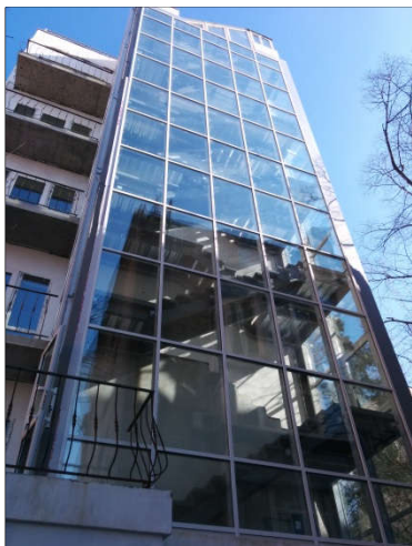
Заказчик: Адвокатская компания Адреса г.Киев Выполненные работы: Остекление фасада здания
