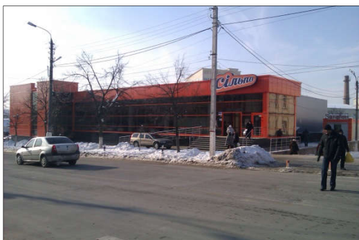
Заказчик: Частный инвестор Адреса г.Васильков Выполненные работы: Остекление и облицовка фасада здания
