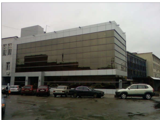
Заказчик: Частный инвестор Адреса г.Киев Выполненные работы: Остекление и облицовка фасада здания
