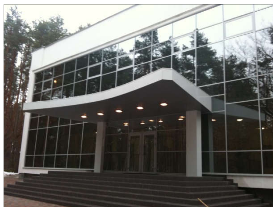
Заказчик: ДП «Конча Заспа» Адреса г.Киев Выполненные работы: Остекление фасада здания
